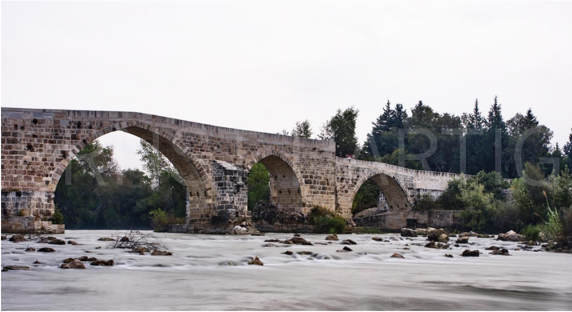
Selcuk Bridge 2022-3108 Photographie
